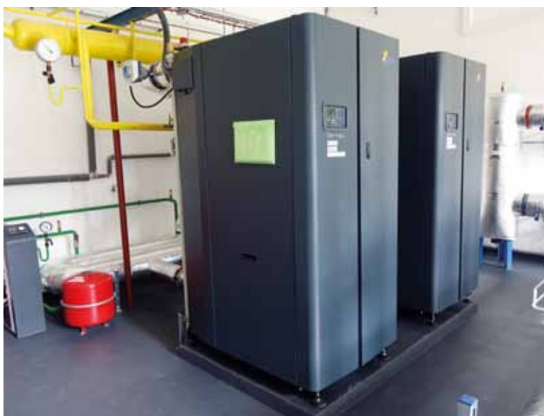
Zrekonstruovaná kotelna výrazně sníží náklady na vytápění. Fotil Josef Hodboď
