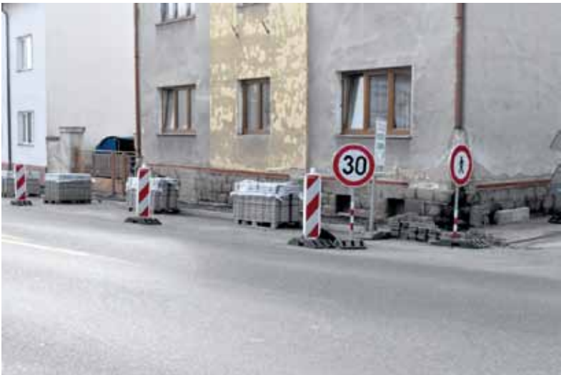
Chodník v Boleslavské ulici prochází rekonstrukcí.
