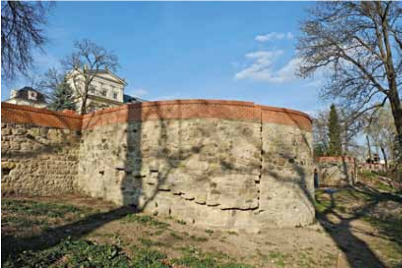
V zámeckém parku probíhá podle plánu rekonstrukce opěrné zdi.
