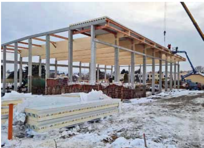
Práce na výstavbě kosmonoské tělocvičny zdárně pokračují.
