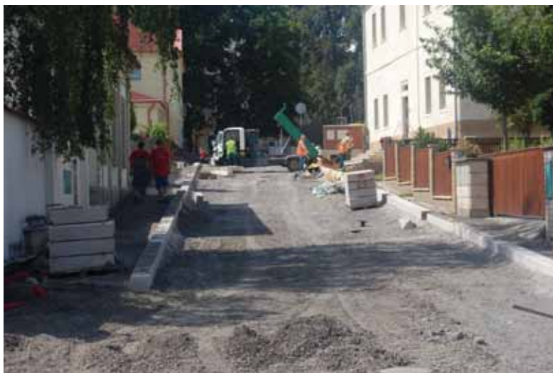
Stavební práce v ulicích jsou téměř dokončené
