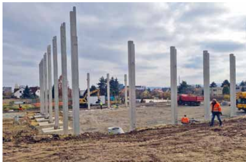
V Kosmonosích pokračuje stavba tělocvičny.
