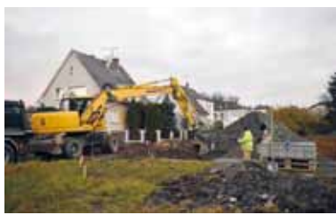
V lokalitě Pod zámkem město dokončuje třetí etapu rekonstrukce.
