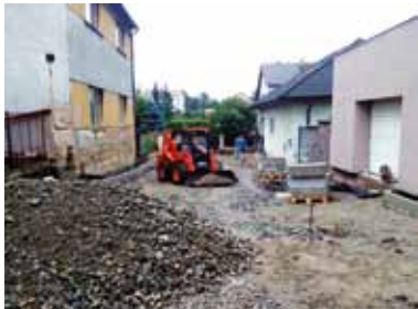
Puškinova ulice je již opravená.
