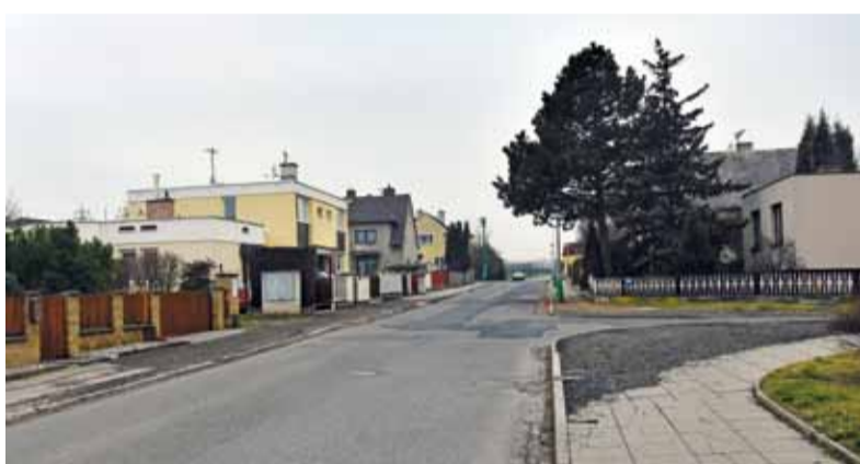
V lokalitě Podzámecká se začne pracovat v Zahradní ulici. Fotil Martin Veselý
