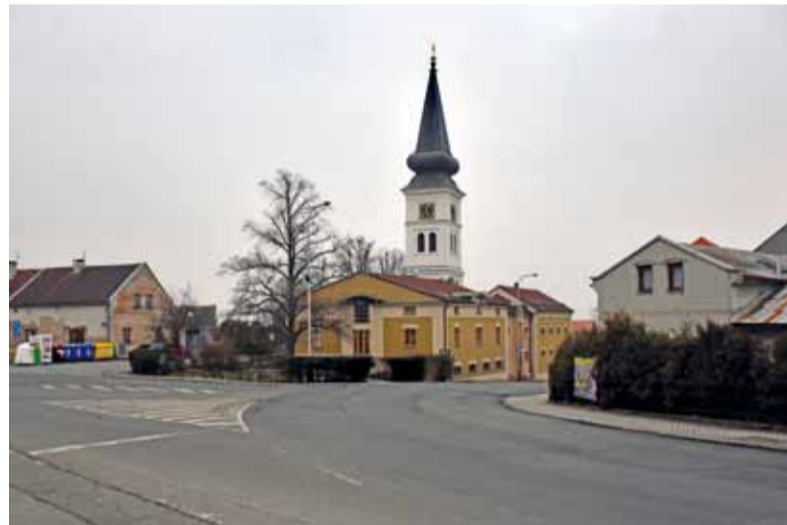
Na začátku března by měla začít rekonstrukce křižovatky U Šmaku. Fotil Martin Veselý
