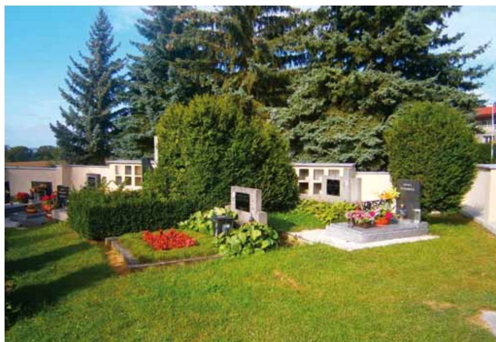
Kolumbárium na hřbitově v Horních Stakorách prošlo rekonstrukcí včetně opravy hřbitovní zdi.
