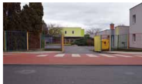
Nově vybudovaný zvýšený chodník u vjezdu do areálu mateřské školy v ulici Pionýrů. Díky tomu už nebude docházet k zaplavení areálu školy.
