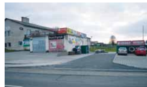
Parkoviště u SK Kosmonosy je po celkové rekonstrukci. Původní ostré kameny nahradily zatravnovací dlaždice. Nový je i samotný vjezd do areálu.
