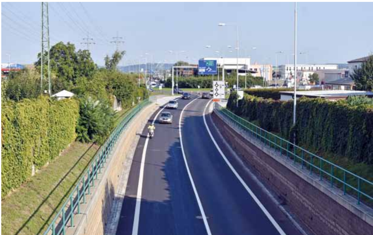
První úsek rekonstruované komunikace I/38 už je obousměrně průjezdný.
