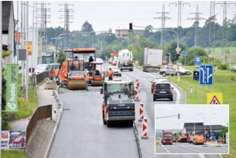
Až do poloviny října čekají řidiče komplikace na komunikaci I/38. Práce na silnici I/38 už jsou v plném proudu. Začaly v první polovině července.
