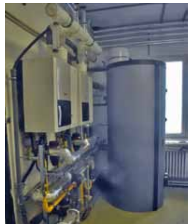
Kotelna ve správní budově SK Kosmonosy prošla rekonstrukcí. Fotl Martin Veselý
