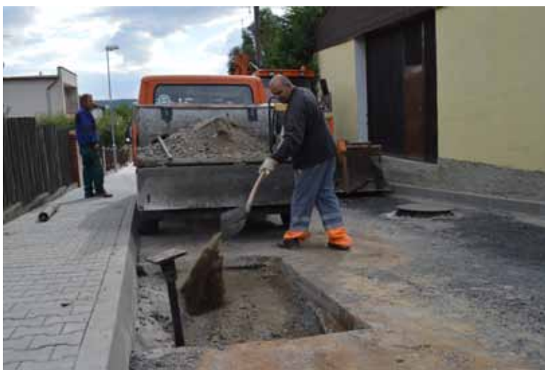
Spodní část rekonstruované ulice Pod Loretou už opustili dělníci. Dříve, než se plánovalo.
