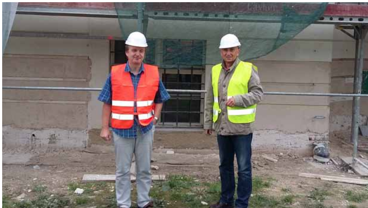
Starosta Müller s Ing. Šimonem na jednom z kontrolních dnů stavby.
