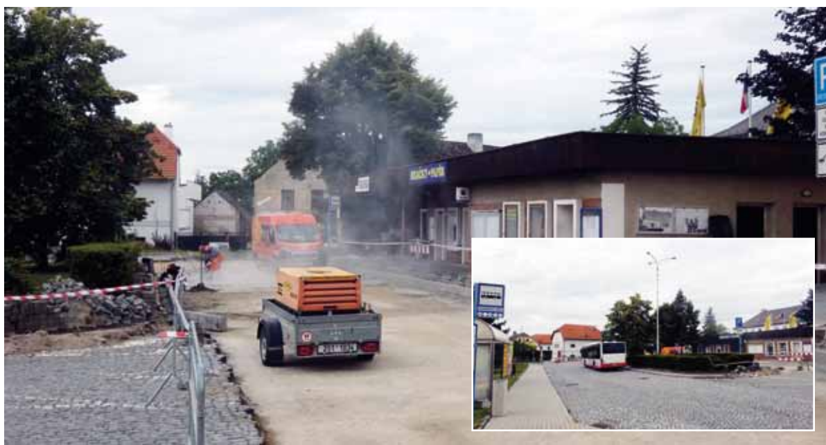
Kosmonoské náměstí prochází během léta rekonstrukcí. Připravena byla oprava dlážděného povrchu. Rekonstrukce se dotkla pochopitelně i autobusové dopravy. Cestující při ní používali provizorních zastávek. Fotil: Jakub František Tomek.
