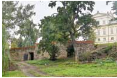
V parku dál pokračují opravy zámecké zdi. Fotil Martin Veselý
