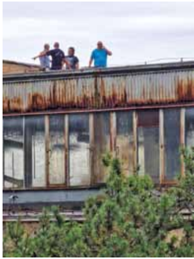
V Psychiatrické nemocnici aktuálně probíhá například rekonstrukce budoucích tří ambulančí.
