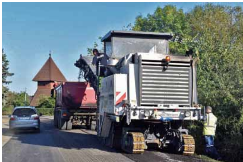
Práce s dokončením kanalizace v Horních Stakorách finišují. FOTIL MARTIN VESELÝ
