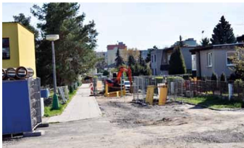
V rámci třetí etapy rekonstrukce lokality Podzámecká pokračuje například rekonstrukce kanalizace.
