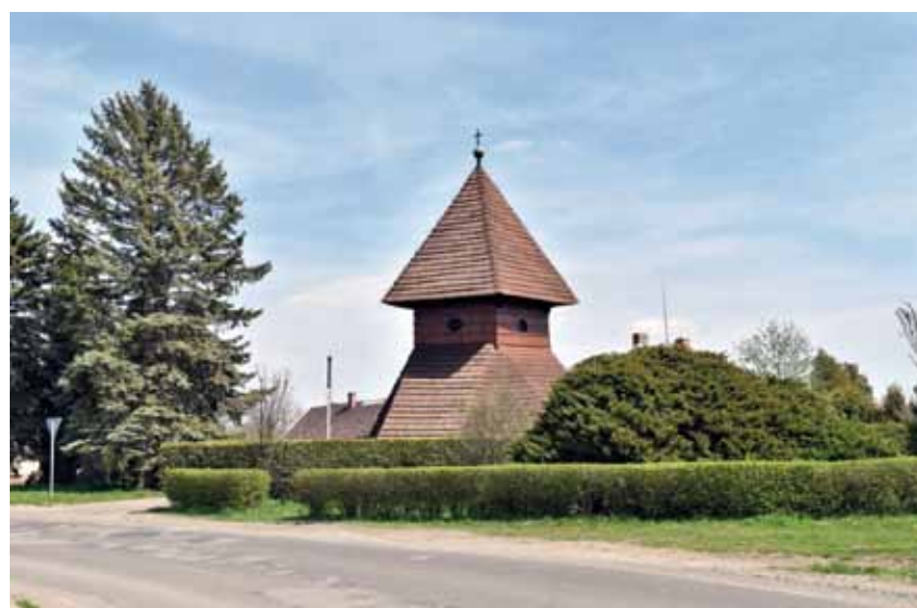
Stakorská zvonice se dočkala ošetření celé vnitřní dřevěné konstrukce. Fotil Martin Veselý
