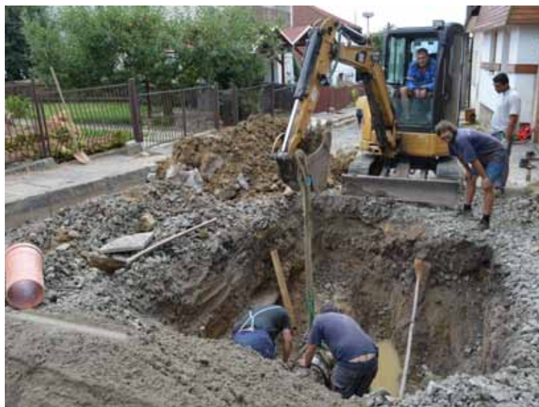
Než se bude možné pustit do výstavby nového povrchu silnice, je potřeba opravit vodovodní řad.
