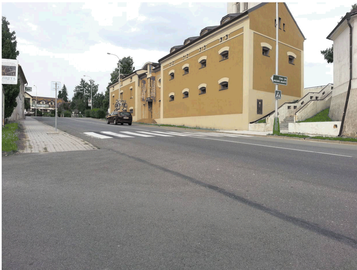
Nadbytečná délka přechodu pro chodce
