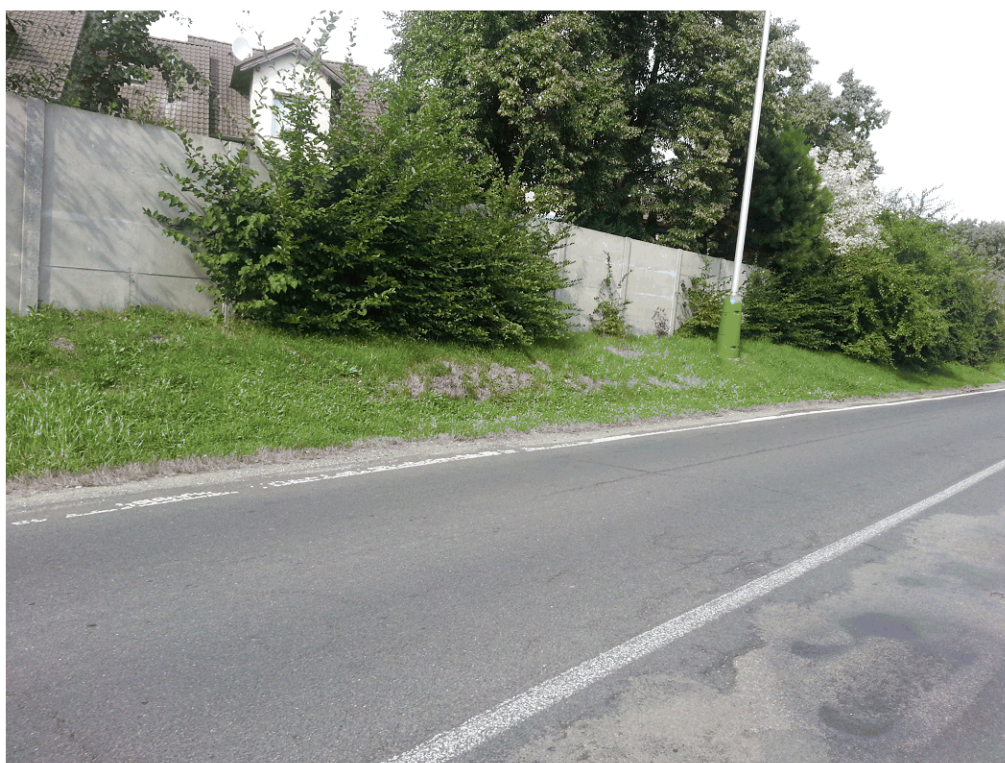
Značný výškový rozdíl mezi stávající vozovkou a přilehlými pozemky sousedních nemovitostí v intravilánu města v koncové části cyklostezky. Umístění stezky sy vyžádá návrh zárubních zdí.
