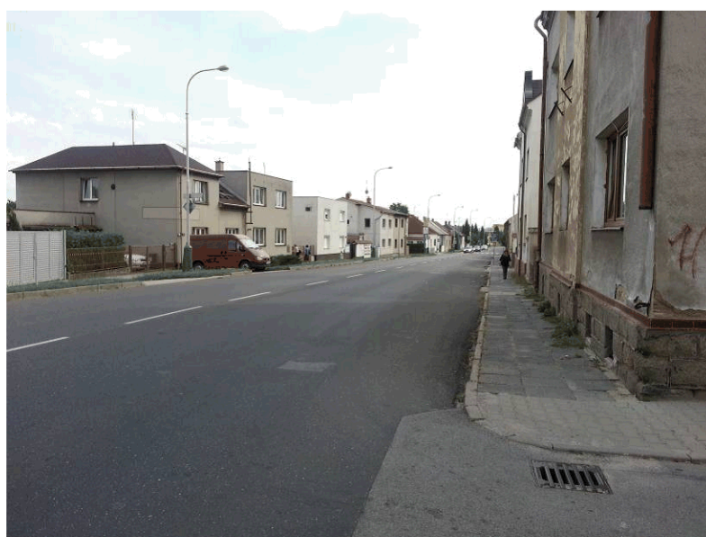
Pohled na stávající stav ve sledovaném úseku
