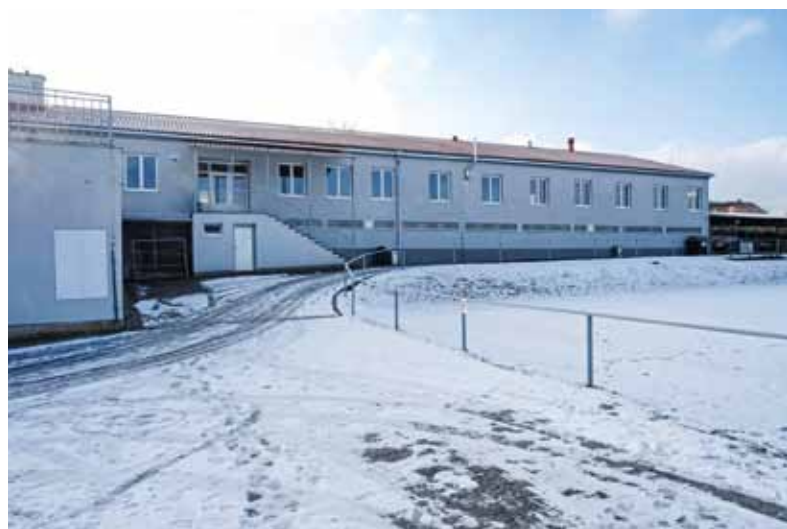
Správní budova areálu SK Kosmonosy. Fotil Miroslav Polach, AZ FOTO MB
