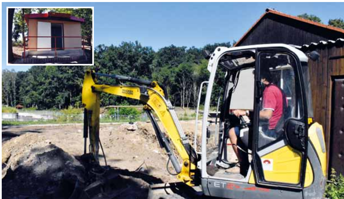
Ve volnočasovém areálu pokračují práce podle plánu. Třeba na rekonstrukci správní budovy, kde vzniknou převlékárny. Návštěvníkům volnočasového areálu jsou nově k dispozici také skříňky. FOTIL: MARTIN VESELÝ
