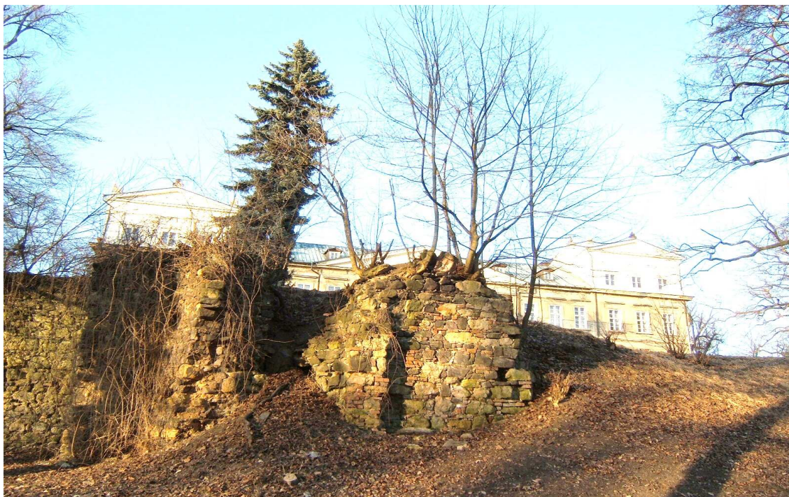
Nálety vyrůstající z polorozpadlé opěrné zdi, smrk v parteru navržen ke kácení
