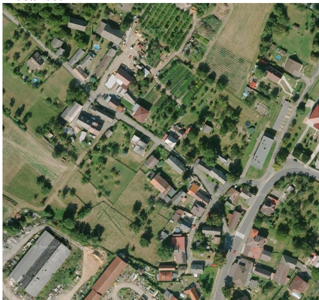
Rozvolněná struktura zástavby – smíšená venkovská zástavba v části Horní Stakory
